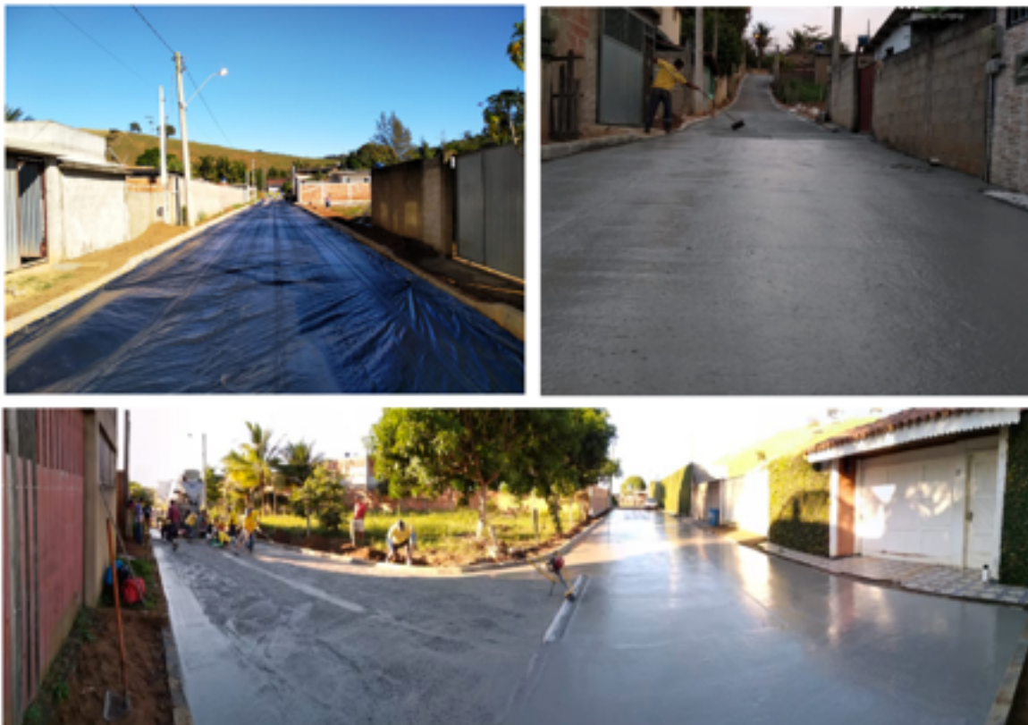
Pavimento urbano de concreto em ruas de Cachoeiro de Itapemirim (ES)
