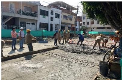
Extendido del concreto con regla vibratoria
