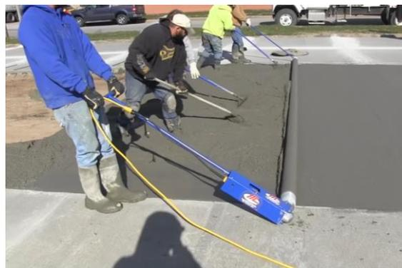
Além do equipamento principal de *espalhamento (adensamento/alisamento)* do concreto, visto acima, a contratada fará uso dos seguintes equipamentos complementares para a correta execução do pavimento:
