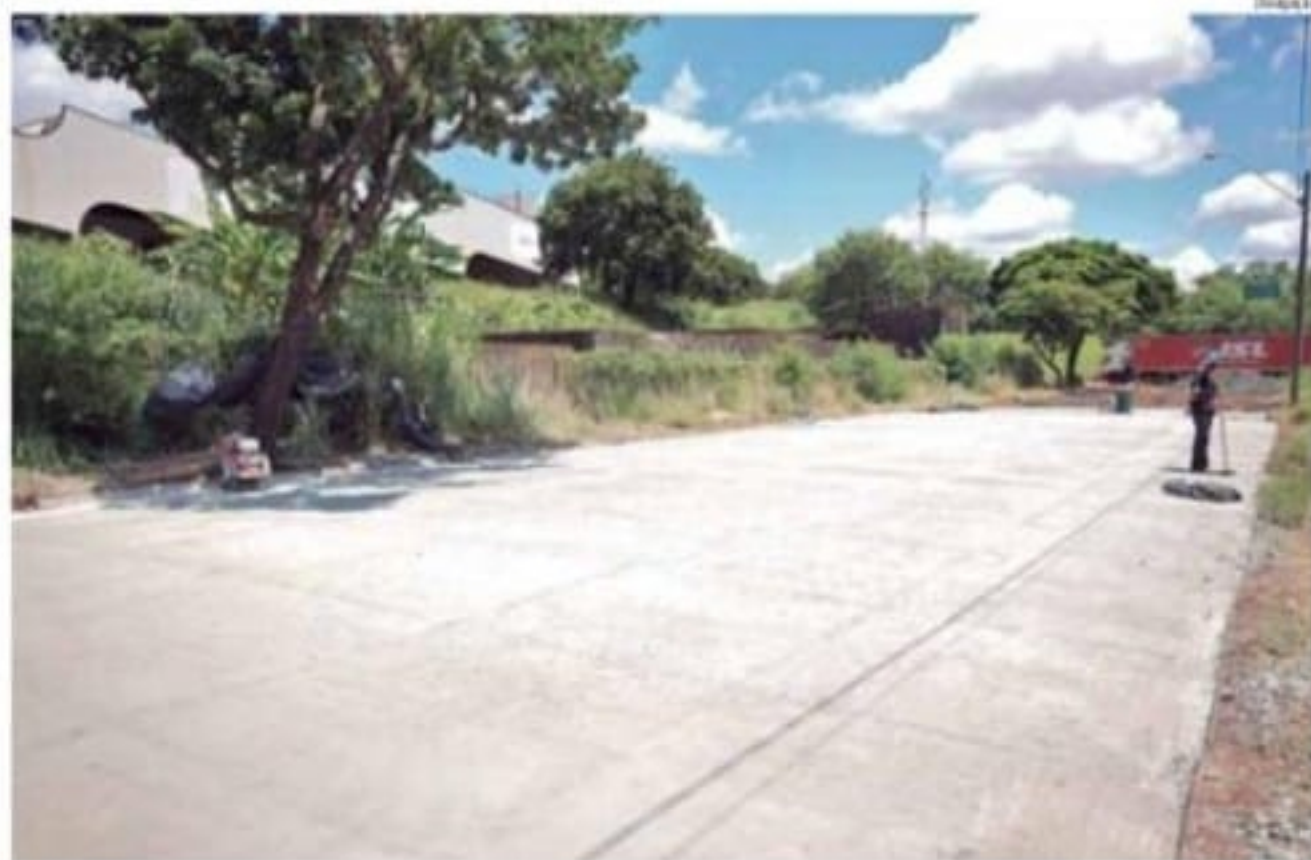
Pavimento de concreto tem maior durabilidade e começou em rua do Unileste
